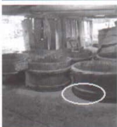
⑦粘土と木製の桶の部分には約2センチ程度の隙間を空け、熱による焦げ付きを防ぐ。釜の設置が終了したら、バケツ3杯程度の水を注ぎ、「さとねり」と同じ重さで自然に粘土と釜を馴染ませる。
