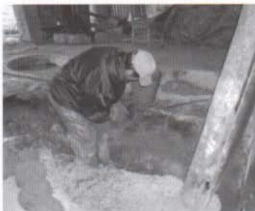
④設置側に球状の粘土を叩き付ける様に塗りつける。
